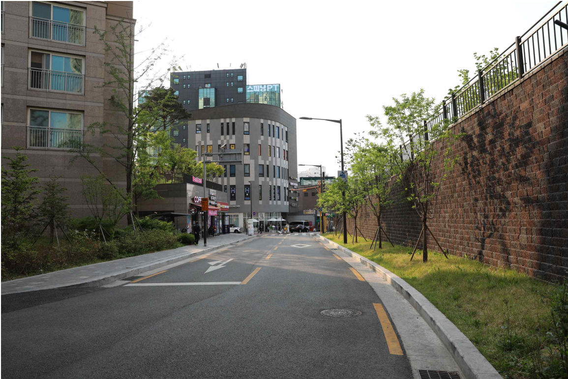
2022. 5. 20. 달맞이길에 자리한 도로의 한 모습을 촬영해 본다. 주변은 상가와 화단으로 되어있고, 이 길이 중심 도로의 한 부분이 되어있다.
